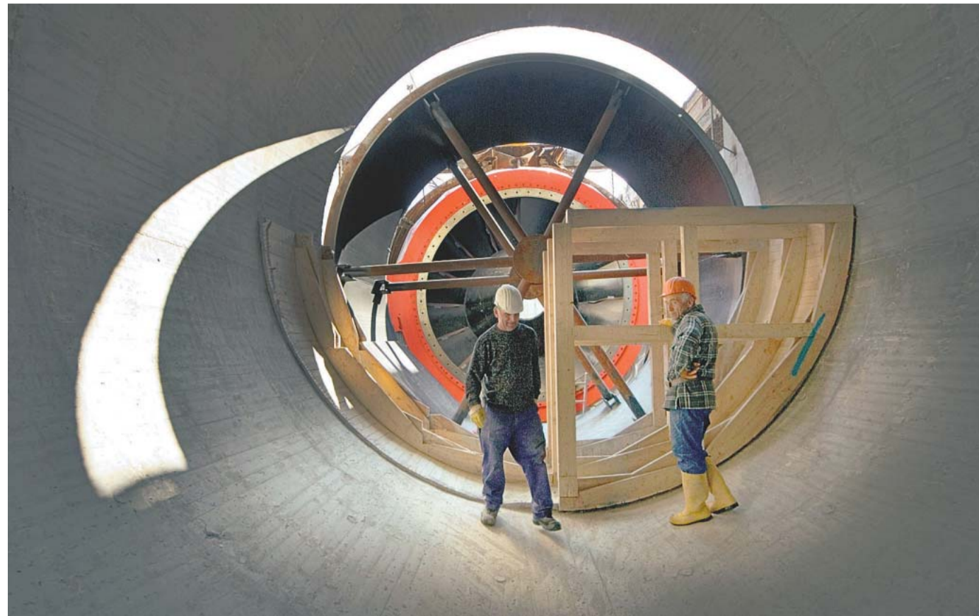
Durchblick I: In wenigen Monaten wird Mainwasser durch diese Röhre strömen
